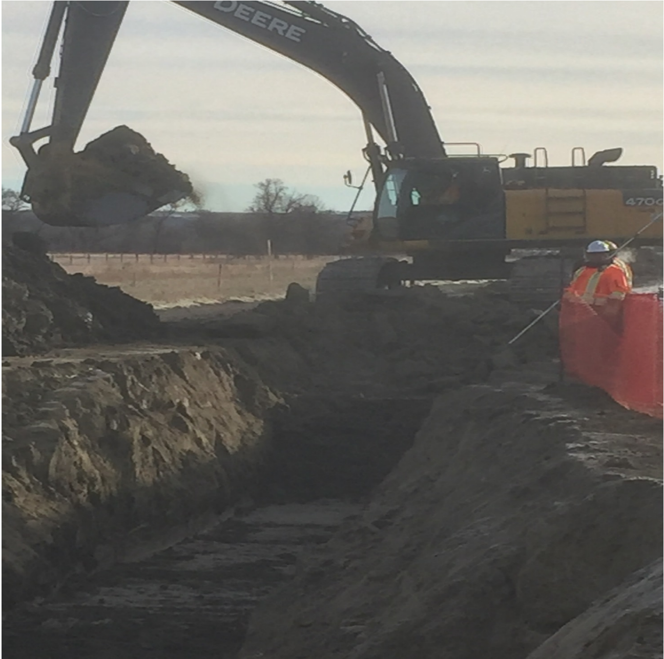
EXCAVATOR TRENCHING DITCH IN THE QU'APPELLE VALLEY
